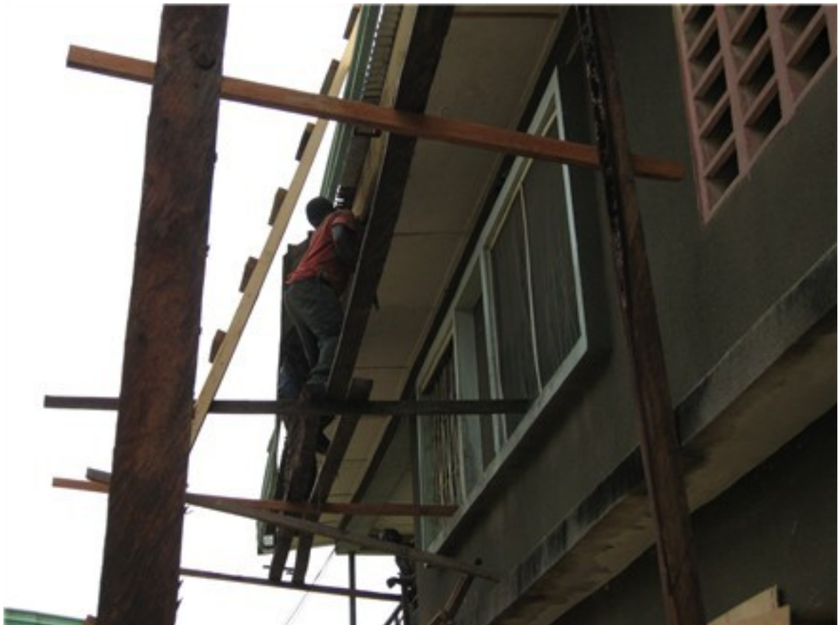
I lavori di ristrutturazione della sede del progetto SSL
